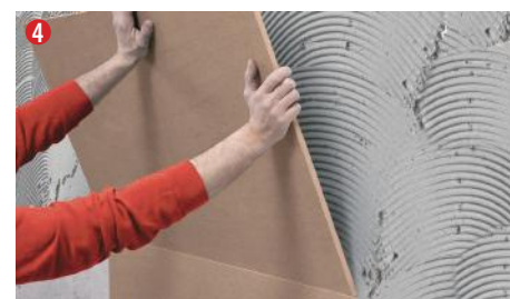
4 Installare la lastra sulla parete
