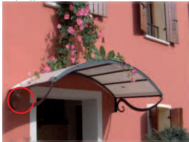
VHS CX vite cl. 8.8 impronta Torx e stellina
